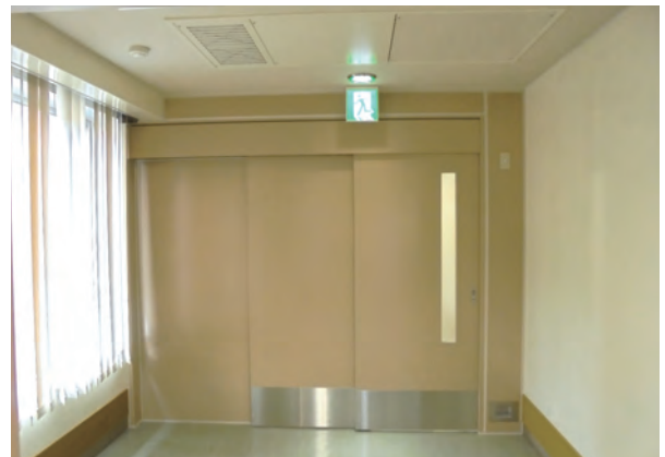
手術室側入口に設置した前室
